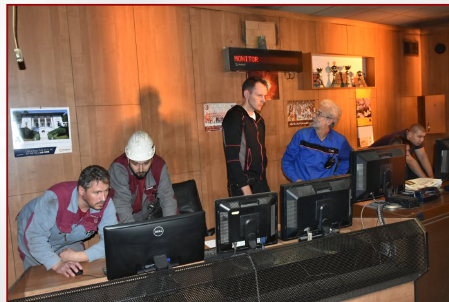
Nové řídicí stanoviště plynočistírny KKO
