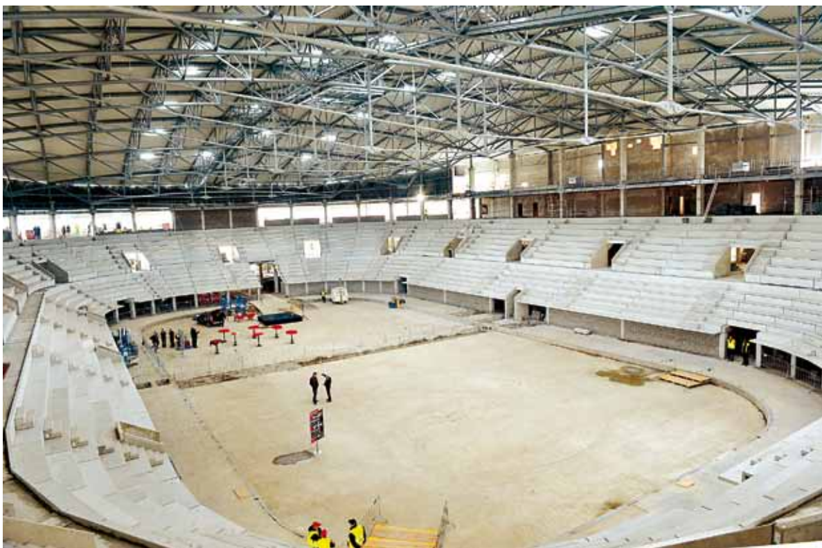
Pohled do útroby rozestavěné Werk arény před začátkem prohlídek pro veřejnost.
