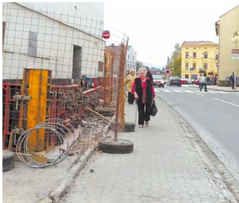
Na rohu Mariánského náměstí vládne stavební ruch.
