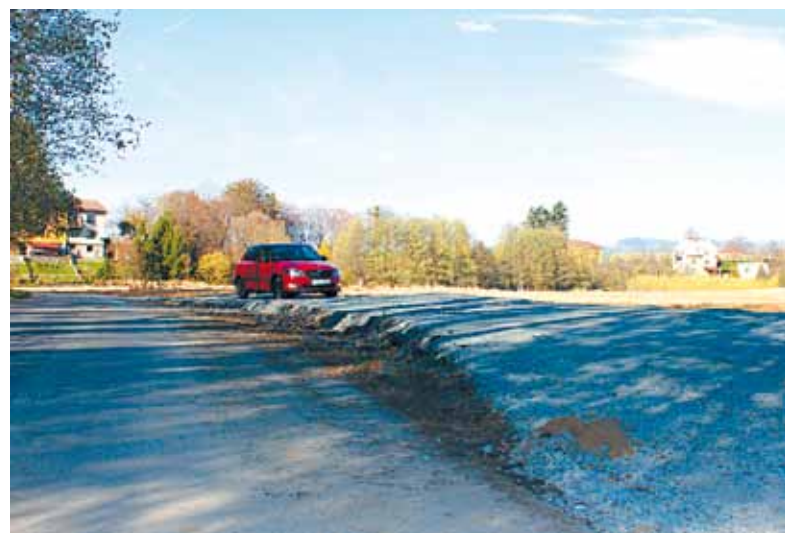
Místní cesta se kvůli pilíři estakády musí posunout. Foto: Petra Martynková
