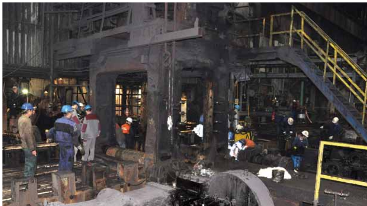
Na blokovně 1 bylo nutné provést výměnu, opravu či repasi v podstatě všech komponentů stojanu.
