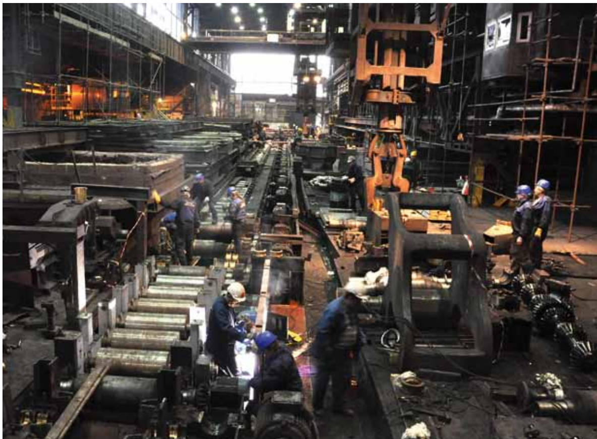
Opravářské práce na úseku valníků před blokovou stolicí u starých hlubinných pecí.
