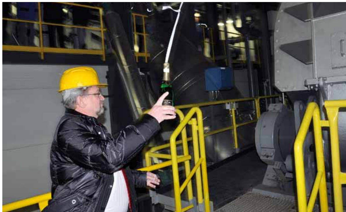
Křtu celého zařízení rozbitím láhve šampaňského o mlýn uhlí se ujal 1. místopředseda dozorcí rady TŽ Ján Moder.
