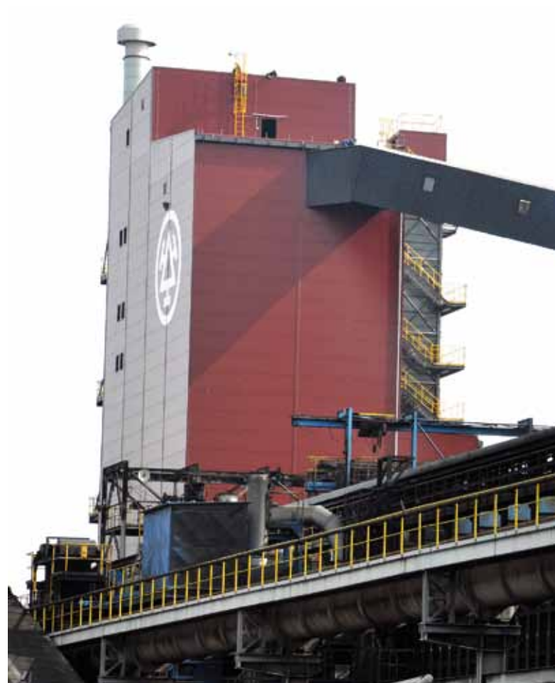
Pohled od KB 12 na dominantní objekt PCI.
