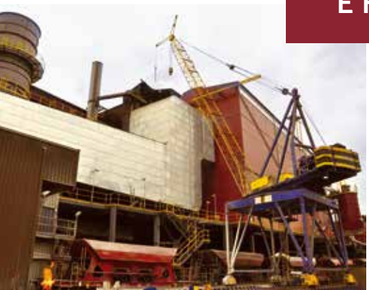
Výstavba sekundárního odprašeni konvertorové ocelárny
